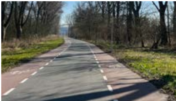
Geasfalteerde Buitensingel met fietsstroken
